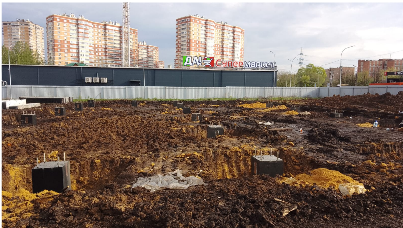
Земляные и фундаментные работы 05 -10 мая 2023 года. Объект: г. Тула Щекинское шоссе.
