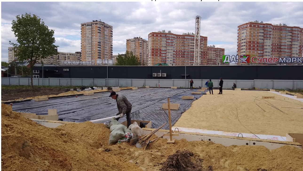
Заливка плиты пола 11 – 16 мая 2023 года. Объект: г. Тула Щекинское шоссе.
